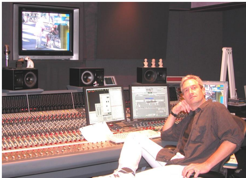
Figure 88 Des moniteurs de proximité posés sur le bord d'une console.
